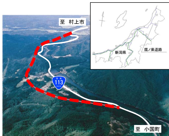
国道113号鷹ノ巣道路 終点側から起点側を望む
