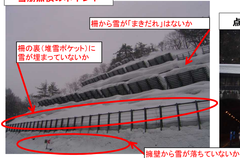
(国道7号 蒲萄トンネル新潟側坑口上り斜面)
