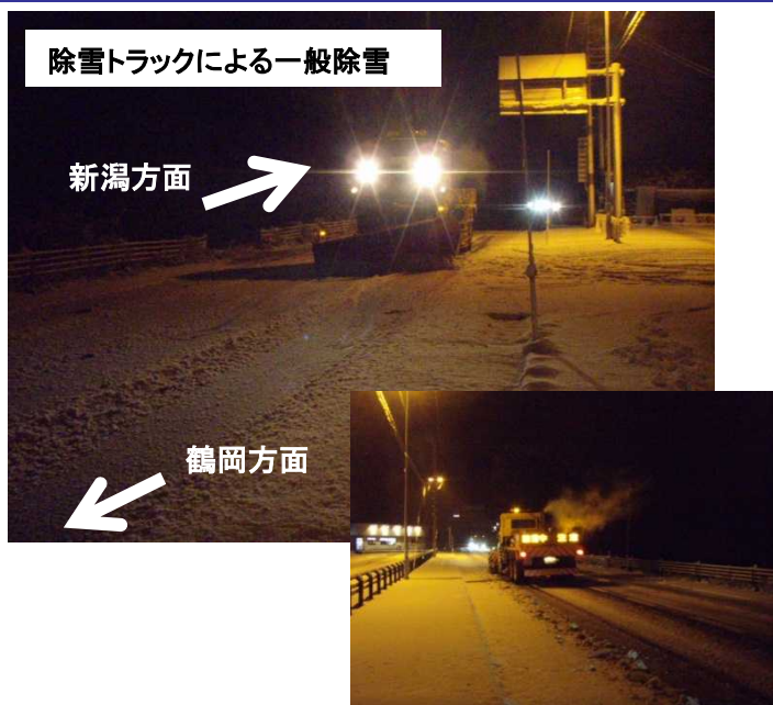
【村上市大須戸除雪ステーション前】
