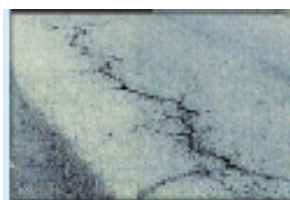
舗装のひび割れ
