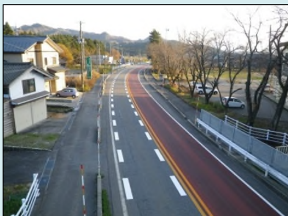
カラー舗装・ドットラインの設置状況
