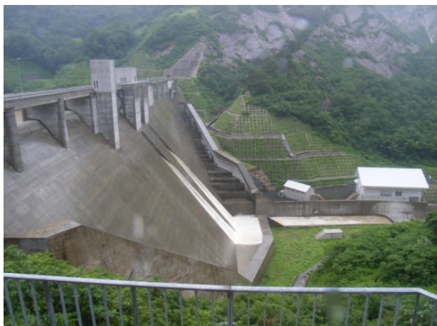
防災操作中の横川ダム
