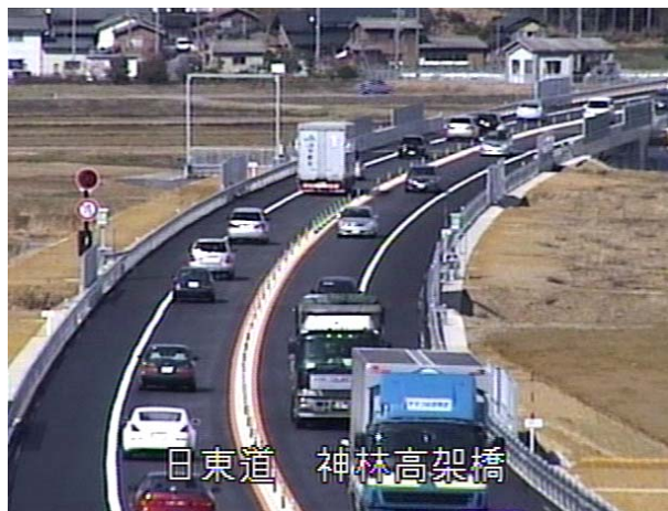
日東道 神林高架橋 (神林岩船港IC～村上瀬波温泉IC間)
