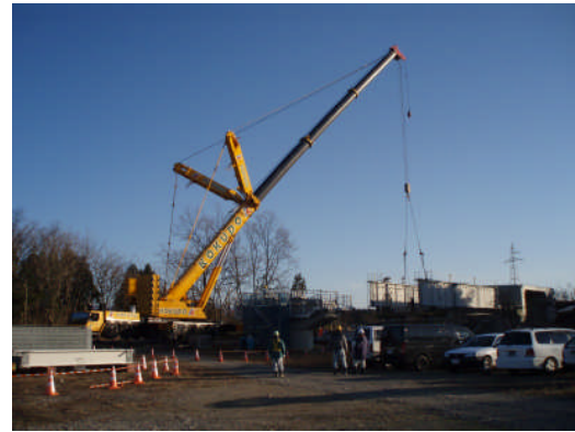
三面川橋（仮称）橋桁架設の施工状況
