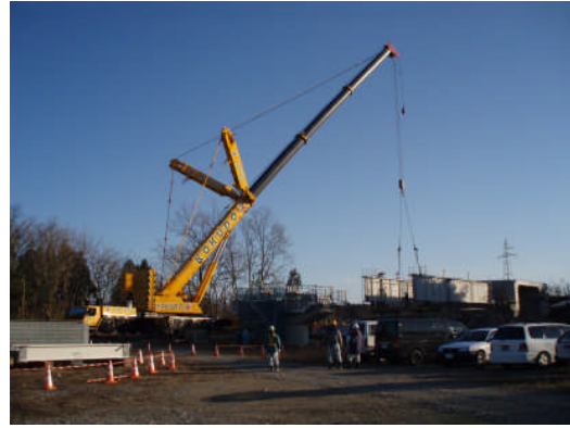
三面川橋（仮称）橋桁架設の施工状況
