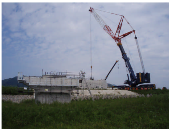
高根川橋（仮称）橋桁架設の施工状況
