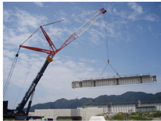
高根川橋（仮称）橋桁架設の施工状況
