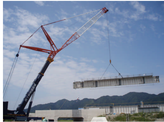
高根川橋（仮称）橋桁架設の施工状況
