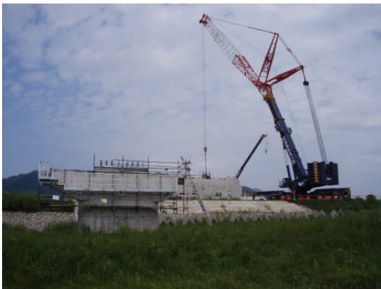
高根川橋（仮称）橋桁架設の施工状況
