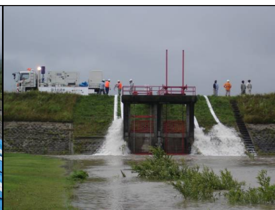
H16 出水出動状況(村上市鳥屋地先)
