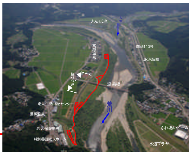
高瀬・湯沢地区（H20.8撮影）
