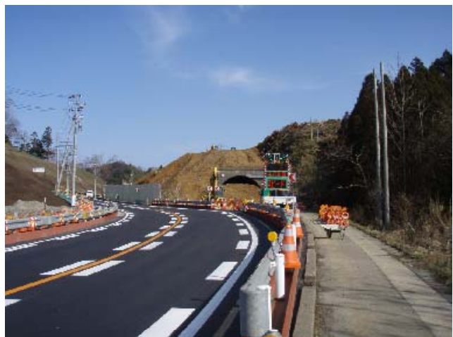
↑ 施工状況 (H20.3)
