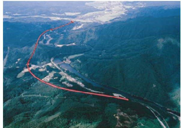
↑ 国道113号鷹ノ巣道路 終点側から起点側を望む
