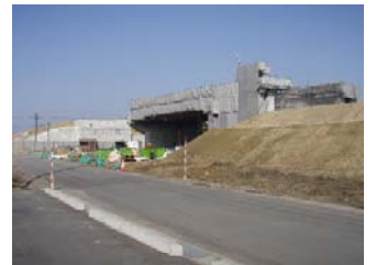
↑ JR跨線橋部（H20.3）
