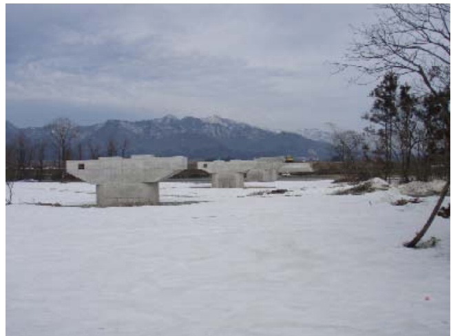
↑ 三面川橋 L = 261m 施工状況 (H20.3)
