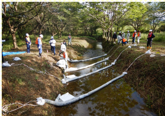
オイルフェンスの設置訓練
