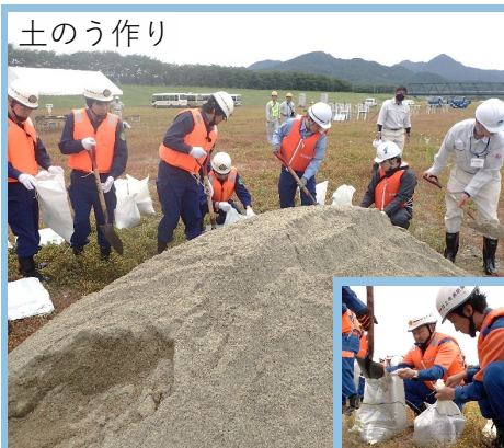
積土のう工(土のう積み)
