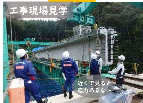
▲ 朝日温海道路の橋梁架設工事を見学し、工場で作られたコンクリート製の部材を現地で組み立てて設置する作業について学びました。
