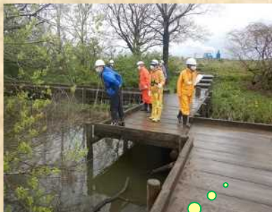
遊歩道が損傷・腐食しているか点検(荒川)
