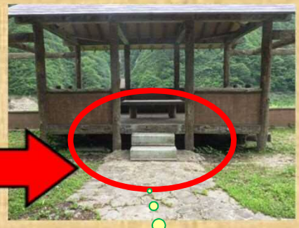
コンクリート製品で階段を作りました
