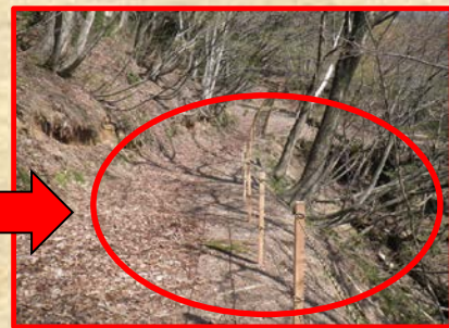
安全柵を再設置しました(ダム)
