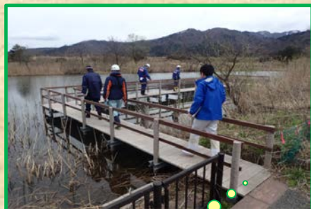
遊歩道が損傷・腐食しているか点検(河川)
