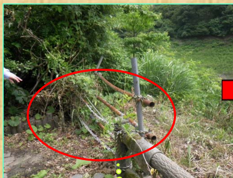
バリケードが一部破損
