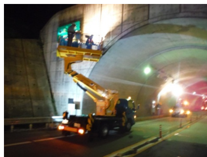
トンネル点検
