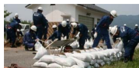
積み土のう工
