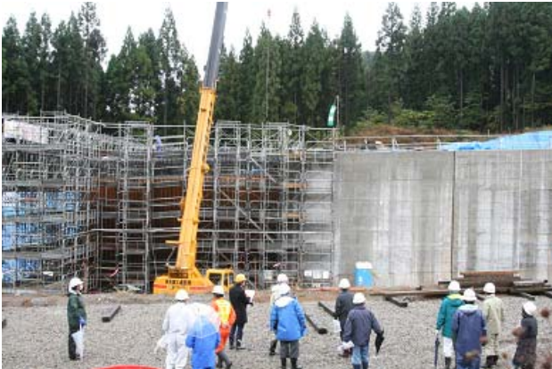
ボックスカルバートの施工状況
