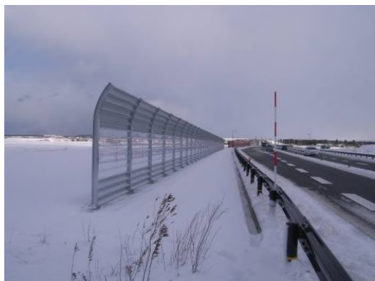
地吹雪防止柵 (地吹雪による視程 障害防止効果)
