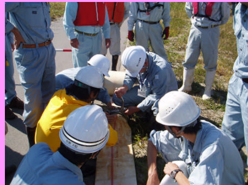
排水ポンプ車に排水ホースを接続している様子
