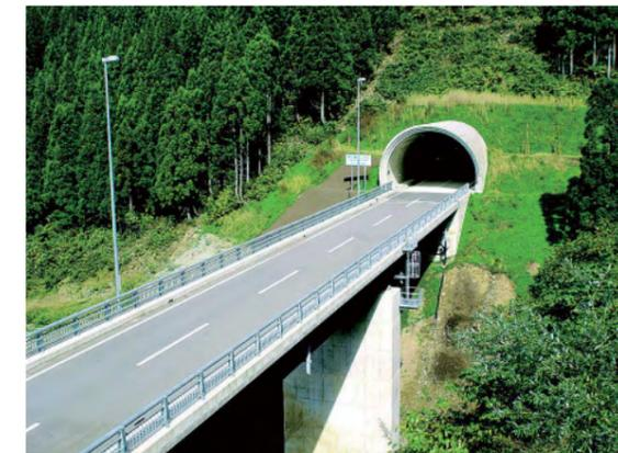
**境の峰トンネル** 逆竹割型の坑口エッジ部に三段の段差を設けることで陰影による表情を与えると共に、進入抵抗感を低減しました。
