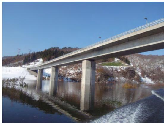
**叶水大橋** 周辺の山並みがなだらかであり、水平ラインがすっきりした印象をだすPC箱桁橋を採用し、橋脚表面にスリットを施工することでスリムな印象を与えるデザインとしました。
