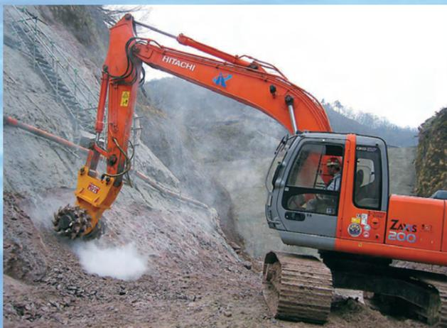
ツインヘッダーによる基礎掘削状況
