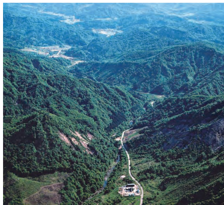
本体工事着手前 平成8年5月25日撮影
