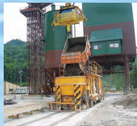
コンクリート製造プラントと トランスファーカによるコンクリート運搬
