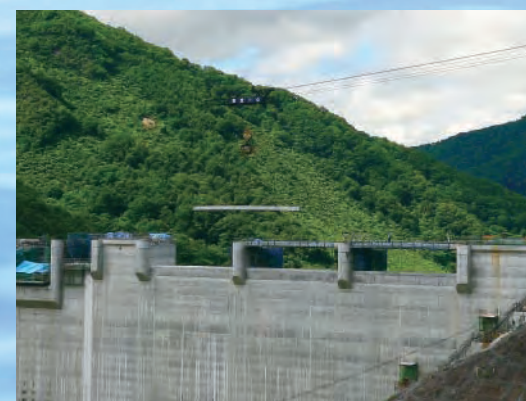
天端橋梁の施工状況
