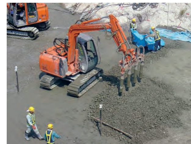
コンクリート締め固め
