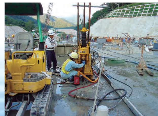
グラウチング処理
