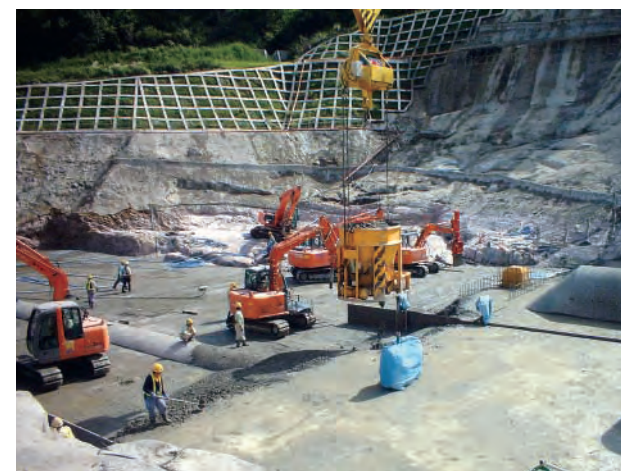
ケーブルクレーンによるコンクリート打設
