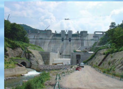
平成18年7月31日 打設完了
