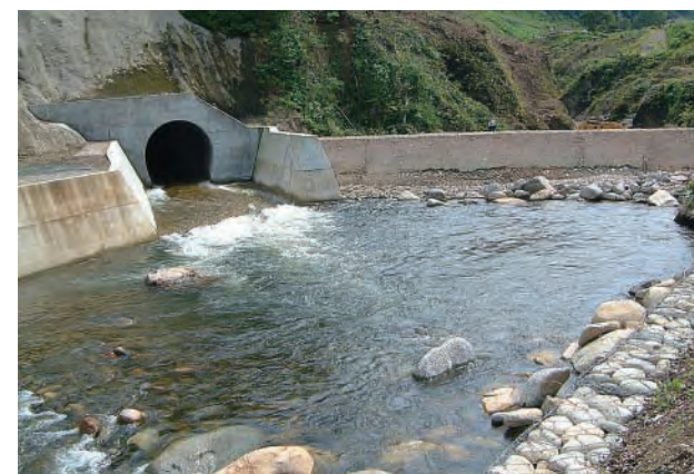
堤外仮排水路トンネル吐口
