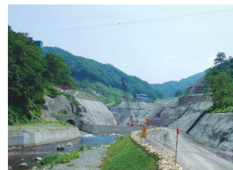
平成16年6月24日 コンクリート初打設
