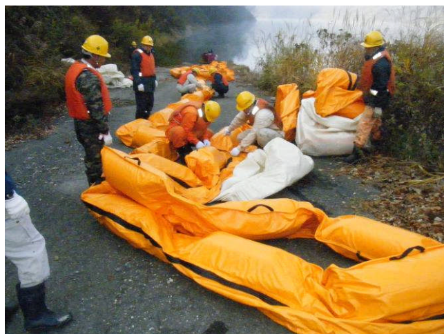
オイルフェンス結束状況
