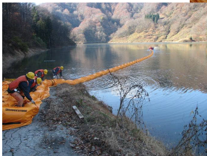
オイルフェンス設置状況
