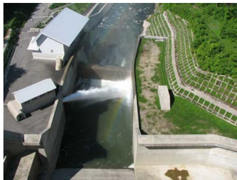
▲利水放流設備からの放流状況 ダム天端から撮影 見頃：6月1日(水)～6月9日(木)
