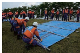
シート張り工
