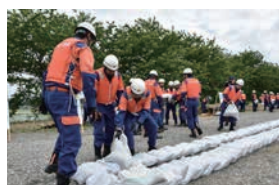
積み土のう工
