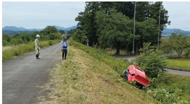
堤防除草(遠隔操縦式)
