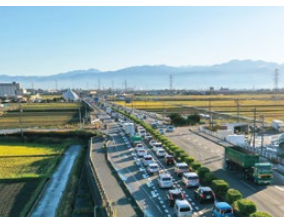
渋滞の状況(田尻交差点付近)
