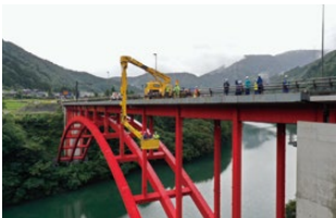
橋梁点検 (国道41号富山市楡原 布尻楡原大橋)
