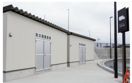
道の駅KOKOくろべ 防災備蓄倉庫
