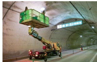
トンネル点検 (国道470号氷見市姿 宇奈比トンネル)
