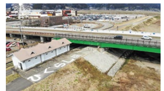
ヘリサインの設置状況(小矢部川、茅蜷橋)
