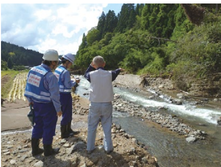
仁行川の被災状況調査(輪島市三井町)
