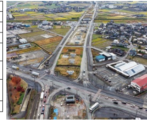
整備が進む、高岡インター入り口交差点付近
