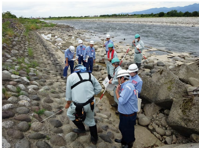
河川管理施設の点検
