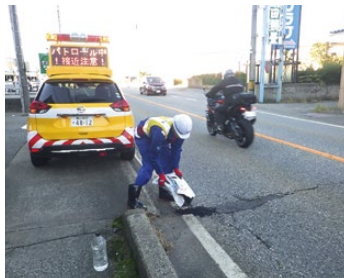
道路パトロールによる路面補修
