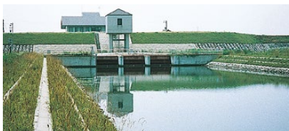
内川流域浄化揚水機場取水樋管
