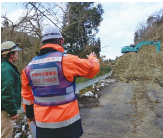
道路啓開作業(珠洲市宝立町)
