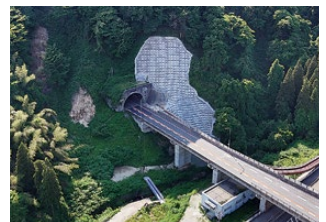
斜面对策 対策後 (国道8号 小矢部市安楽寺)
