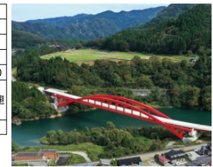
整備が進む(仮称)猪谷橋
