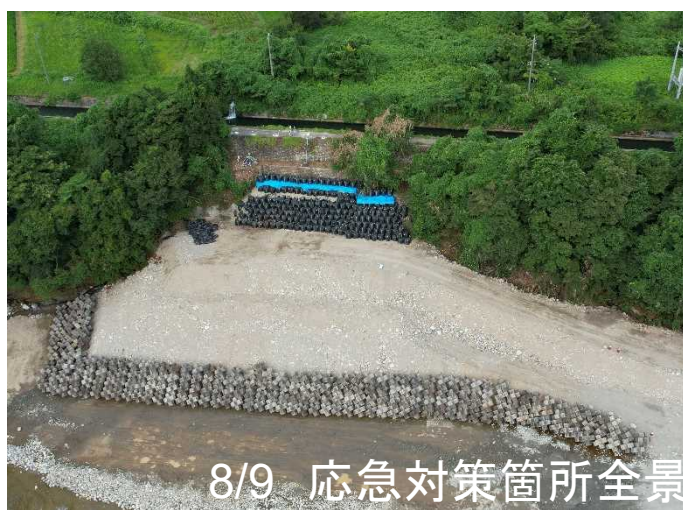
8/9 コンクリートブロックの設置状況
