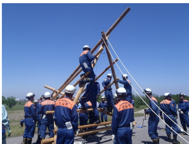
川倉工 組み立て状況
