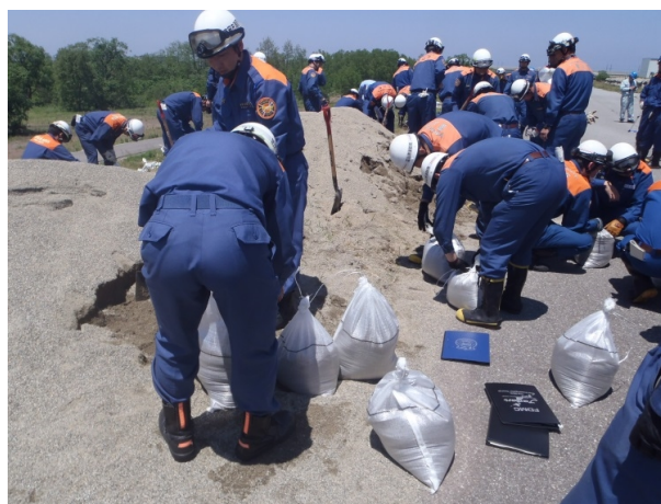
積み土のう工 作業状況
