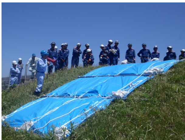
シート張り工 作業状況
