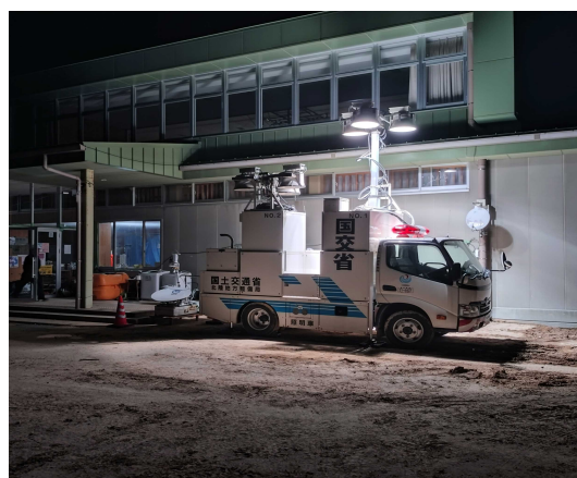
9月23日 照明車による電源支援
