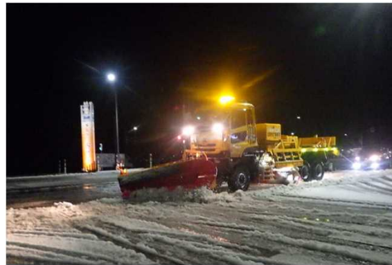
国道8号 小矢部市桜町 さくらまち における作業状況
