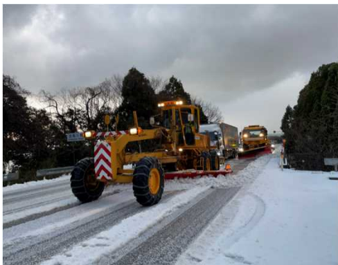
国道8号 朝日町境における作業状況 <過去初出動との比較>
