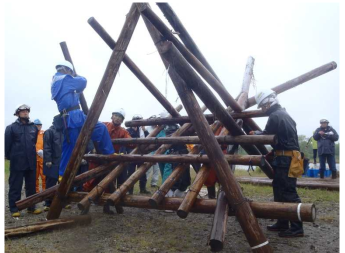
川倉工 組み立て状況
