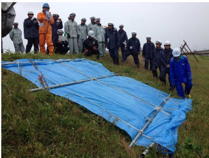
シート張り工 作業状況
