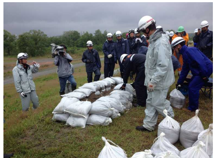
積み土のう工 作業状況
