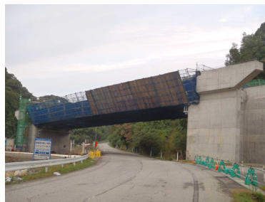
中波跨道橋（仮称）
