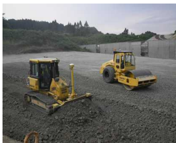
大規模盛土工事
