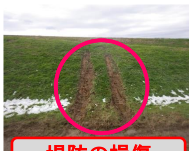
堤防の損傷
