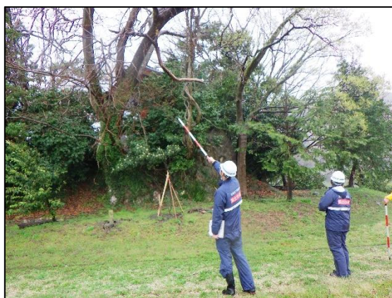
庄川弁財天公園 【枯死による倒木、枝の落下の有無】
