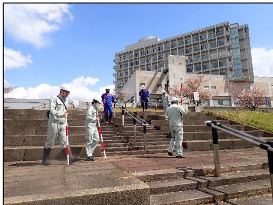
神通川桜づつみ緑地 【枝の落下、護岸の空洞】
