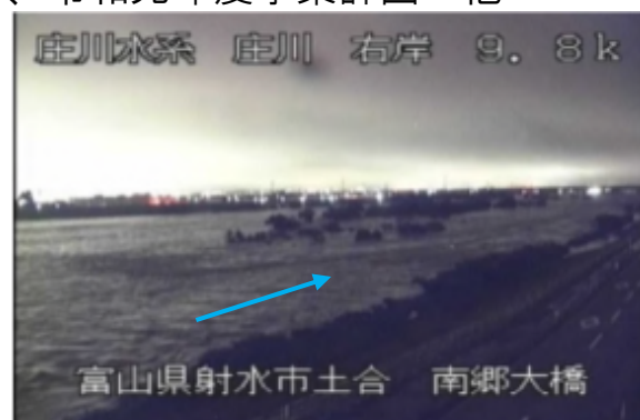
出水状況 (H30. 7. 7)
