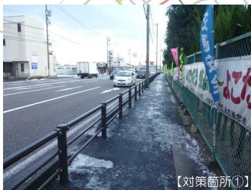
【対策箇所①】 国道8号高岡市宮田町 横断防止柵
