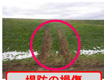
堤防の損傷
