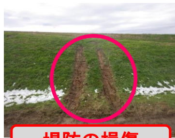
堤防の損傷
