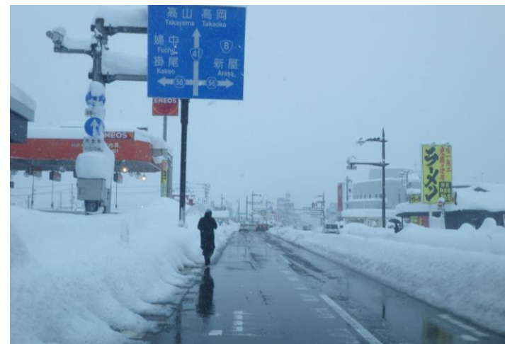
消融雪装置区間（国道41号）
