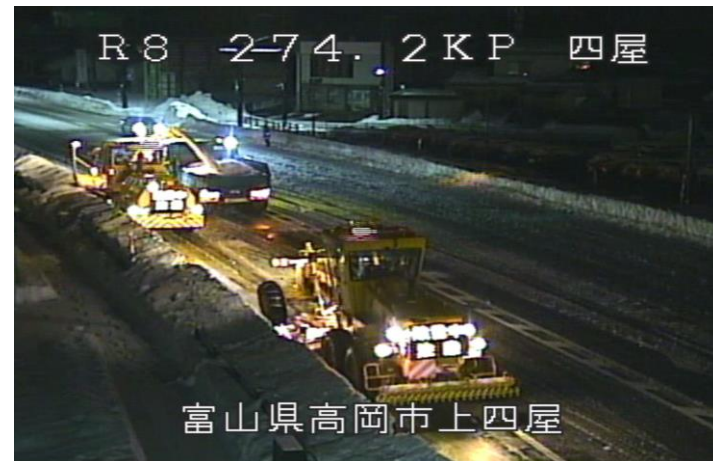
富山県高岡市上四屋 滞雪の運搬・排雪（国道8号）
