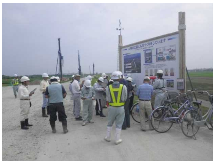
工事説明用の看板
