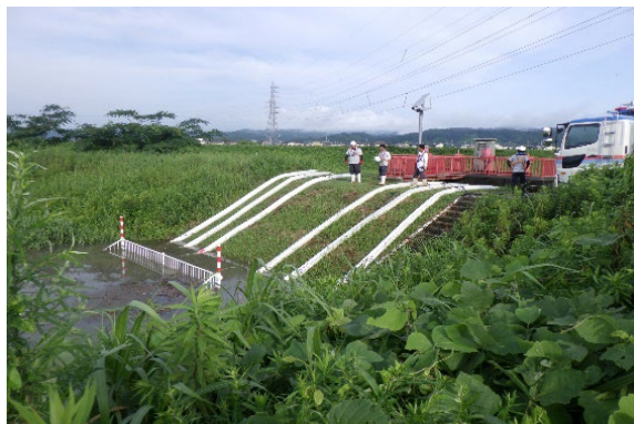
排水ポンプ車による排水活動状況（小矢部川水系祖父川）
