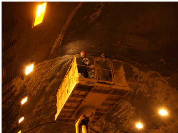
(高所作業車による点検状況)
