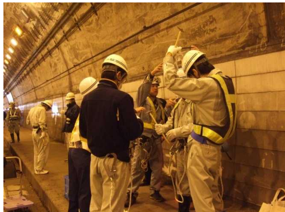
(トンネル側面の点検状況)
