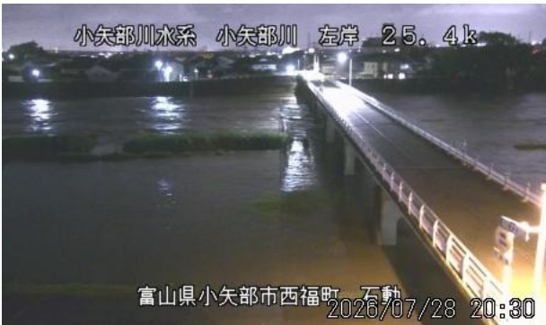
小矢部川 石動観測所付近 (7月28日 20:30頃)
