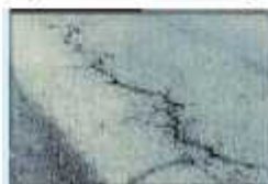
舗装のひび割れ
